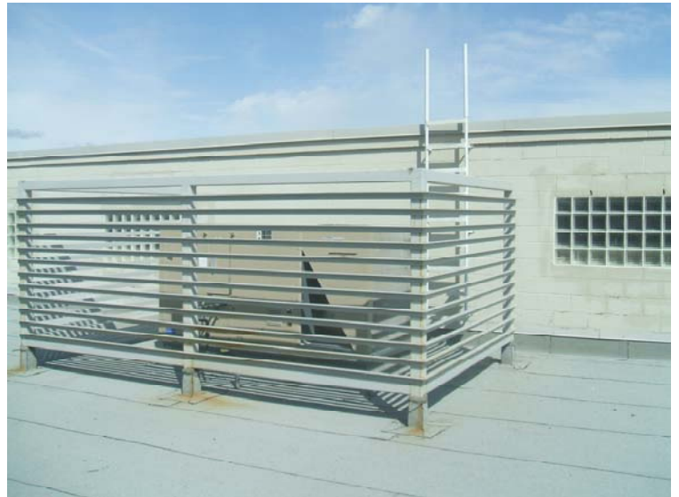
12. Print Shop RTU.JPG
