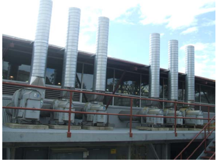
10. Welding Exhaust Fans.JPG
